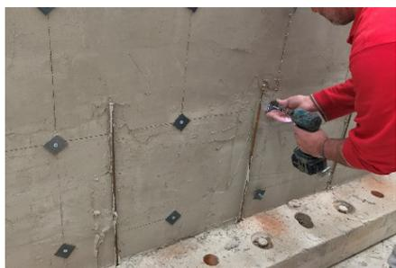
Foto 2: Applicazione dei connettori annegati nello spessore dell'intonaco
