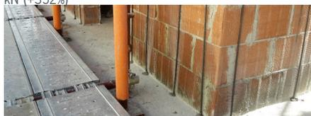
**ARMOH®** è utilizzato come intonaco strutturale per il consolidamento di murature in mattoni in cui sia necessaria un'elevata resistenza a flessione e taglio.
